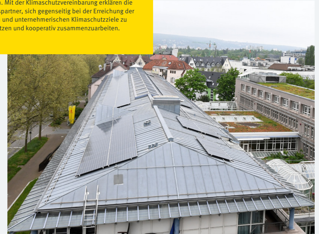
Photovoltaikanlage auf dem Dach der Lotto-Zentrale.
