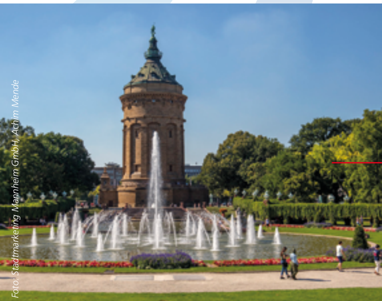
Er ist das Wahrzeichen Mannheims, aber sonst nicht öffentlich zugänglich. Am 8. September haben Besucher die Möglichkeit, den Wasserturm von 11-16 Uhr zu besichtigen.
