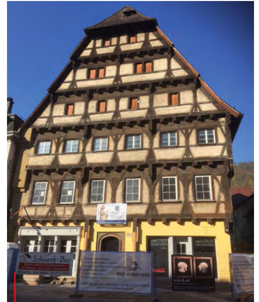
Der „Alte Zoll“ in Geislingen an der Steige ist ein eindrucksvolles Zeugnis mittelalterlicher Holzbaukunst: Dreigeschossiger, giebelständiger Fachwerkbau mit fünf Giebelvorsprüngen und seitlichem Aufzugsgiebel. Innenhof und Treppenturm können von 13:30 bis 17 Uhr besichtigt werden.
