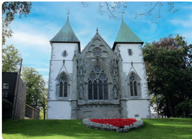
Die „Stavanger Domkirke“ von 1125 ist die älteste Kathedrale Norwegens.
