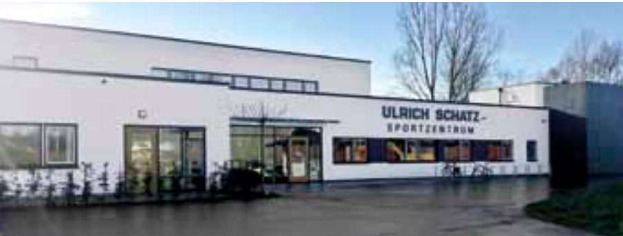
Mit dem Bau des Sportvereinszentrums im Sportpark Rems in Schorndorf errichtete der Verein SG Schorndorf einen sozialen Knotenpunkt in der Stadt. Ermöglicht wurde dies dank Lottogeldern.
